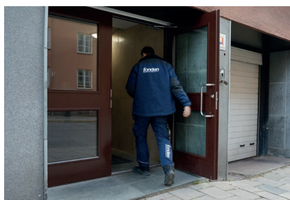
I början av november blev de nya entrédörrarna på Ploggtan monterade
