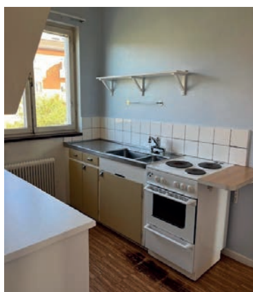
Exempelbild på kök före renovering.
