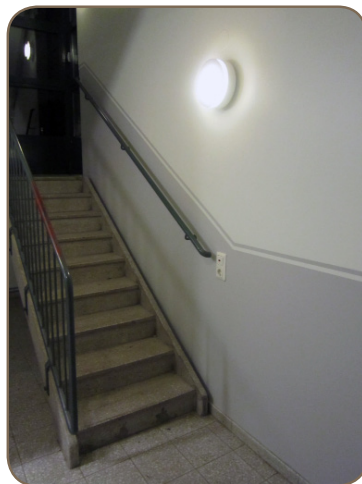
Ommålat trapphus på Söderberga Allé 1 med ny belysning.
