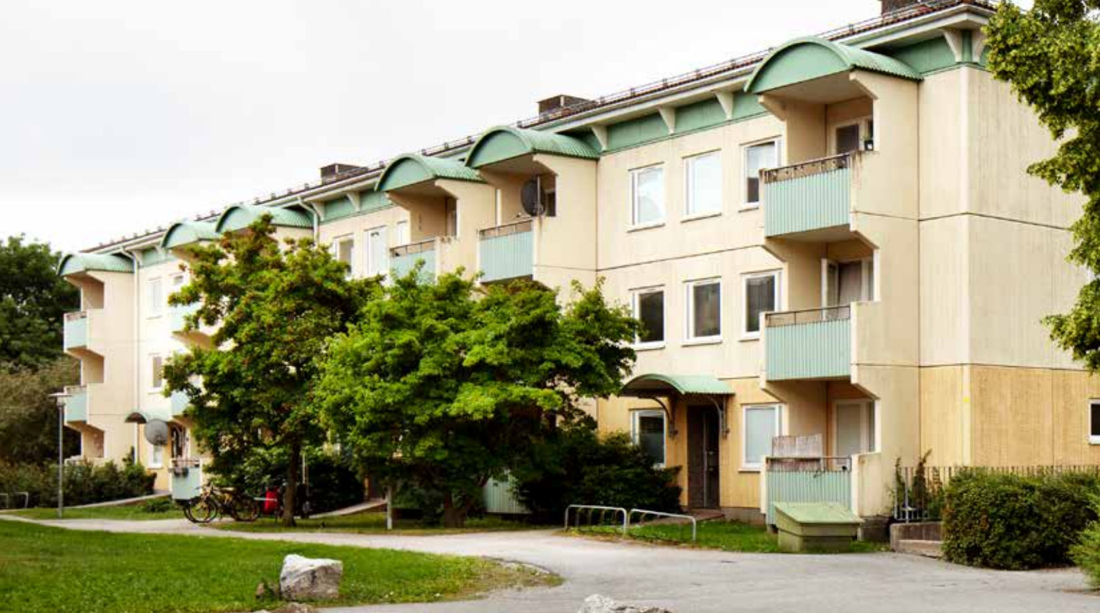
Vid Söderberga gårdsväg har flera matavfallsmolokar jämte sorteringsbehållarna installerats. Foto: Nina Broberg
