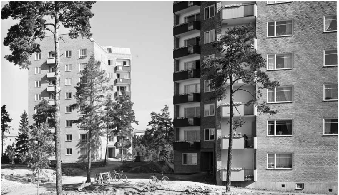
Fastigheten till höger: Störtloppet 2, år 1951. Foto: Sune Sundahl/ArkDes
